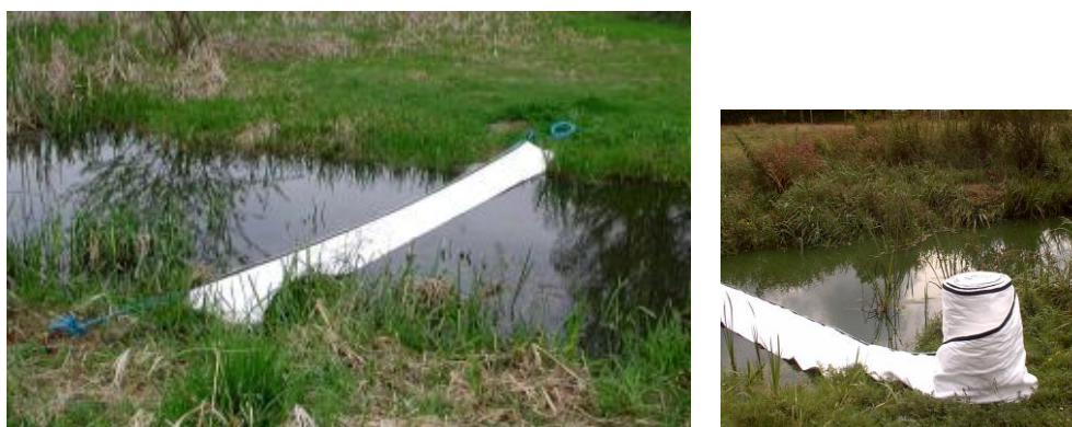
Taśma sorbentowa usytuowana na wodzie
